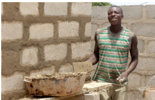
Ardeur et bonne humeur chez les maçons
