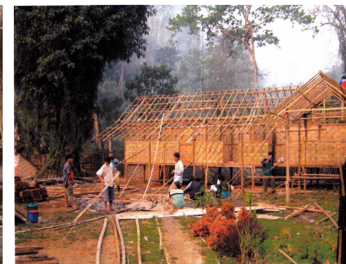
CONSTRUCTION D'UNE ECOLE
